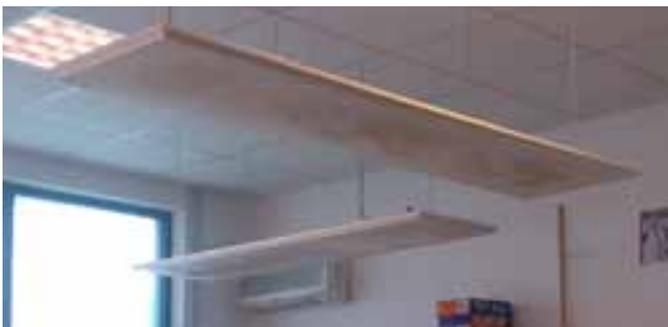
I Pannelli Radianti per Soffitto Thermal Technology® sono adattabili a qualsiasi situazione (integrati nei pannelli del contro-soffitto, fissati a soffitto, sospesi ad una determinata altezza, ecc...), sono smontabili e recuperabili con estrema facilità. I Pannelli Radianti sono ideali per riscaldare specifiche zone o posti di lavoro in un singolo ambiente ad esempio officine, magazzini, laboratori, chioschi o porticati di ambienti pubblici come bar, ristoranti, ecc...
