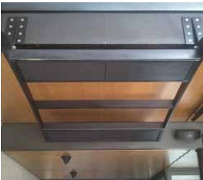
I Pannelli Radianti ad Alta Temperatura sono particolarmente indicati per il riscaldamento di grandi ambienti dove è difficile alzare la temperatura dell'aria.
